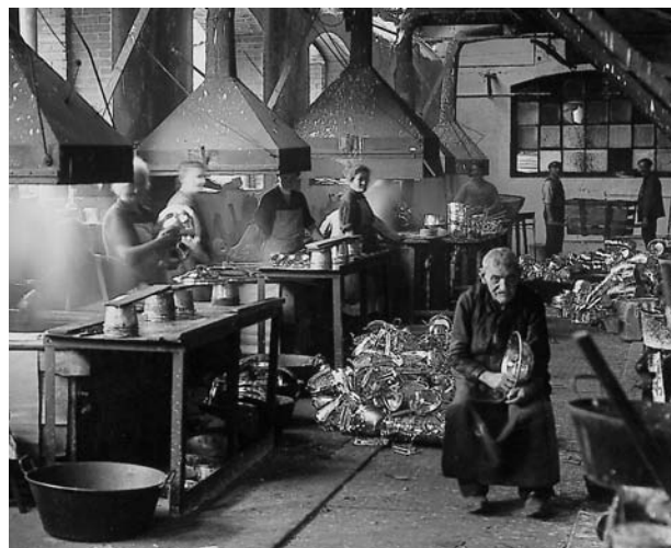
Usine de la casserie à Feschés-le-Châtel
